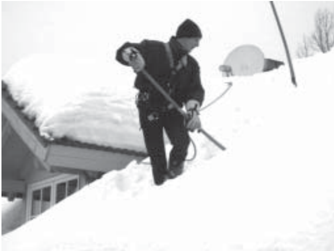
Die Schneelasten haben viele Dachschäden verursacht
